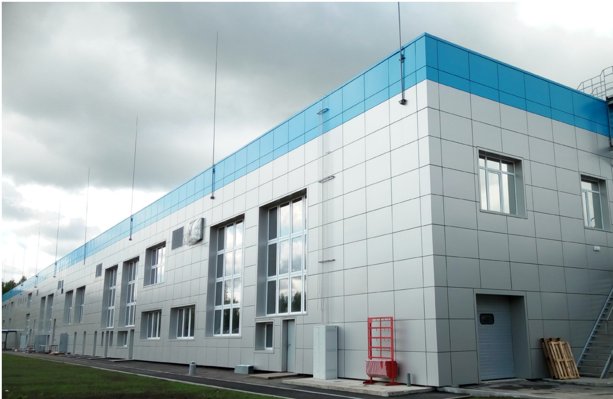
Po rekonstrukci | After reconstruction | После реконструкции
