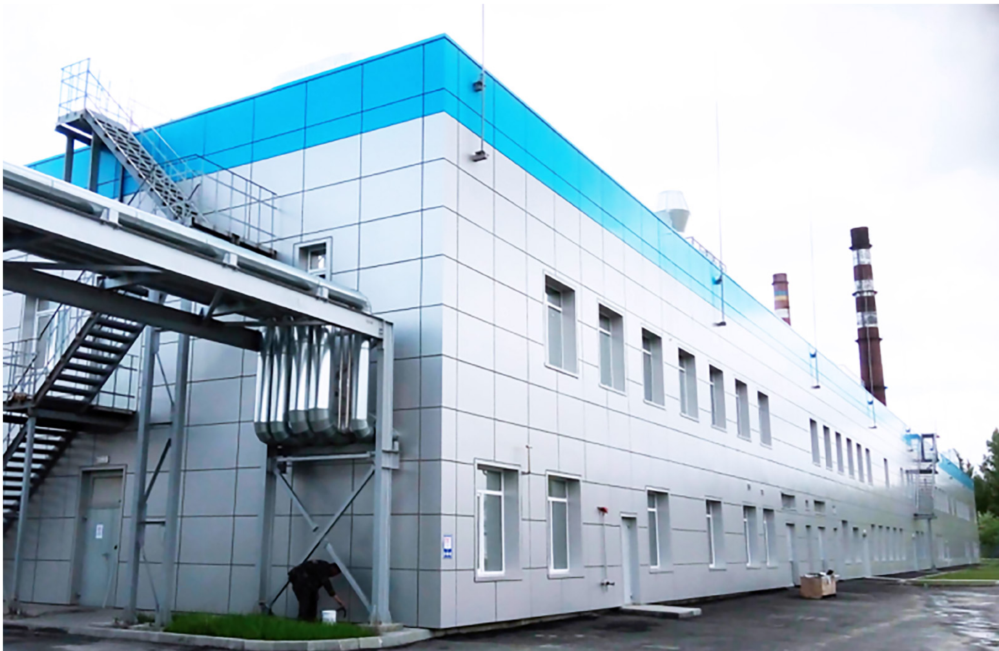
Po rekonstrukci | After reconstruction | После реконструкции
